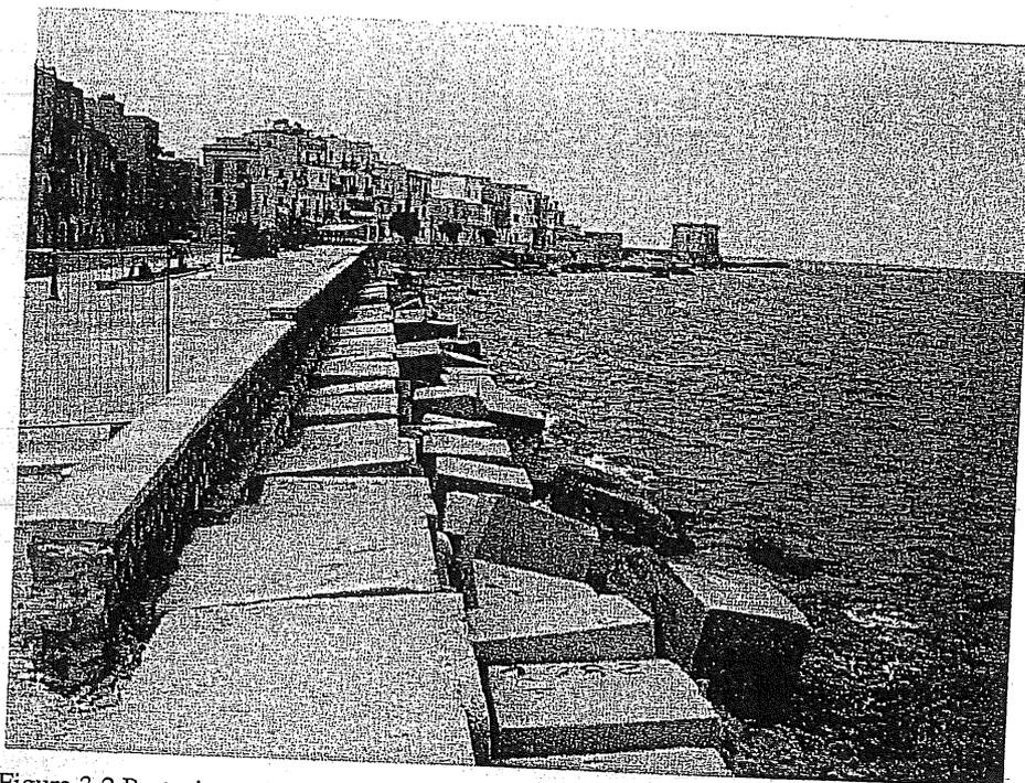
Figura 3.2 Protezione al piede del muro lungo Viale delle Sirene, mediante il posizionamento di massi artificiali.
