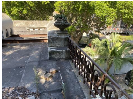
Vista in copertura
